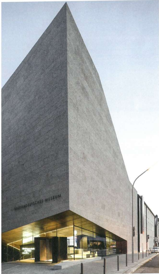
n entsteht ein skulpturaler Kopfbau. The sculptural end building on the south side.
